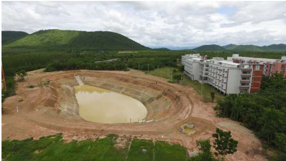
รูปที่ 18 ภาพ บ่อที่ 6 ความจุ 60,000 ลูกบาศก์เมตร ตั้งอยู่บริเวณด้านหลังหอพักหลังที่ 3 เพื่อกักเก็บน้ำในการอุปโภค บริโภค ให้กับราษฎรในพื้นที่ตำบลรางบัว และ มจร.ราชบุรี
